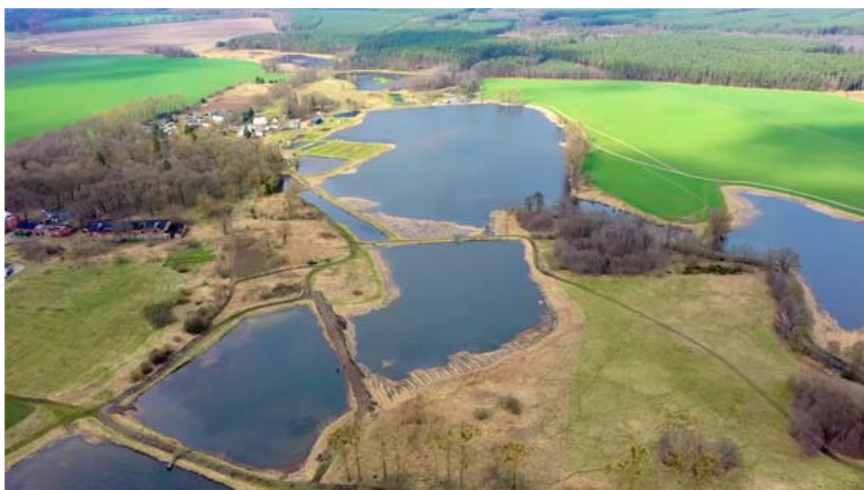
Rys. 1. Rzut gospodarstwa z lotu ptaka przed inwestycją
